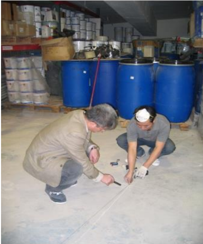
Vyznačenie pozície kladných elektród na betónovej doske
